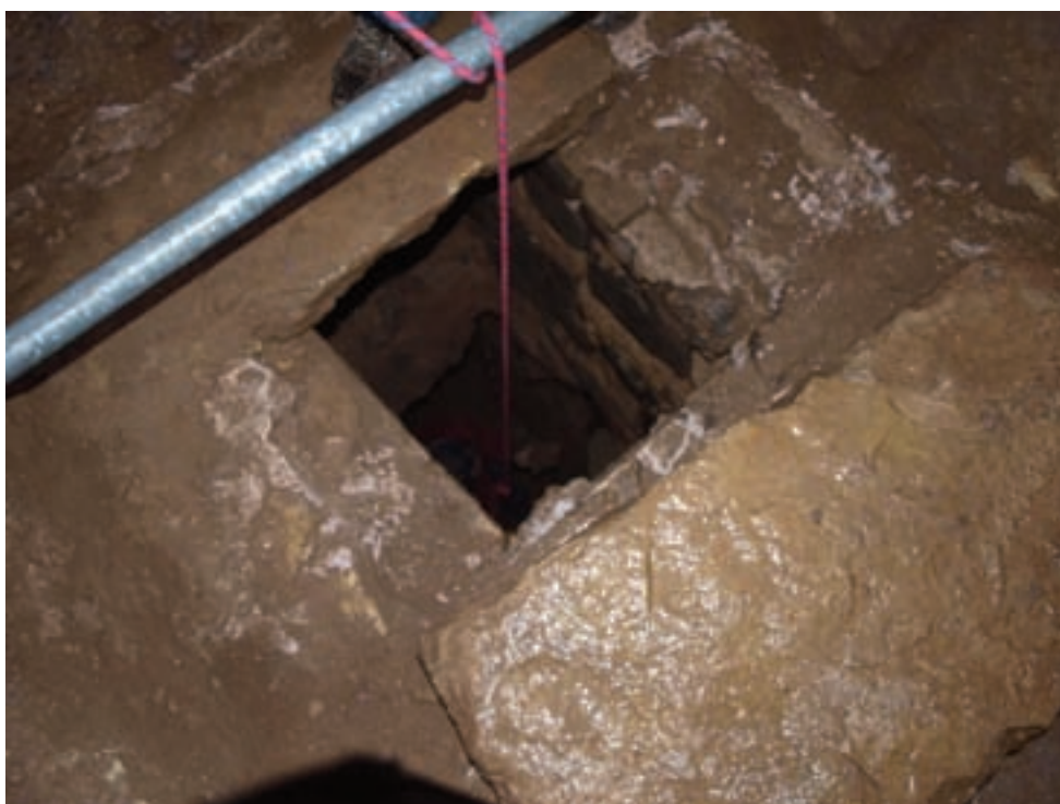
Lámina 23. Acceso a la cloaca.
