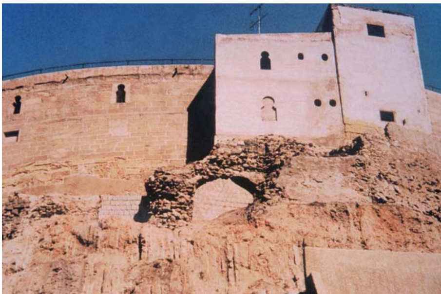
Fig. 3. Detalle de la construcción de la plaza de toros sobre las estructuras del Anfiteatro.
