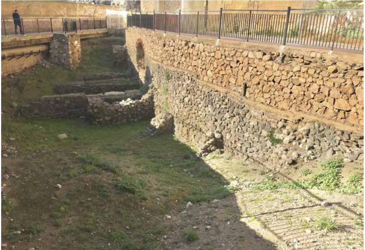
Fig. 4. Muro de cierre y contrafuertes exteriores en la zona meridional del anfiteatro, entre la plaza de toros y el antiguo Hospital de Marina.
