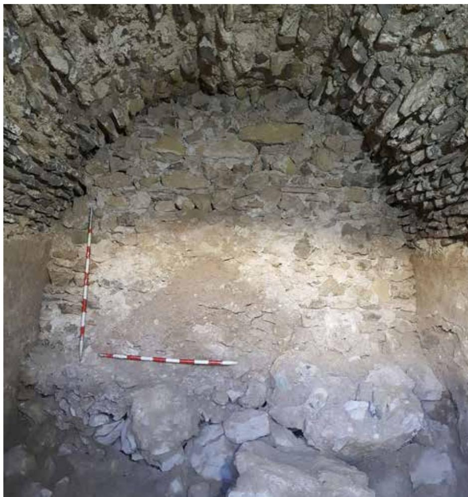
Fig. 15. Imagen frontal del tapiado de la estancia central del eje menor coincidente con el muro exterior de la plaza de toros.
