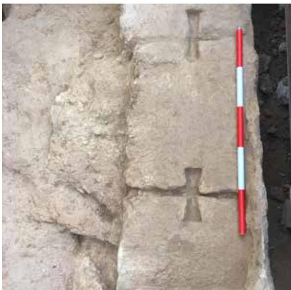
Fig. 9. Huella de grapas en cola de milano que traban los sillares del muro del *podium*, zona sureste.
